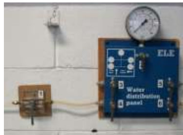
Panel de control de válvulas
